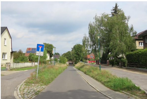
Abb. 6: Unterführung der Bahntrasse durch das B-Plangebiet
