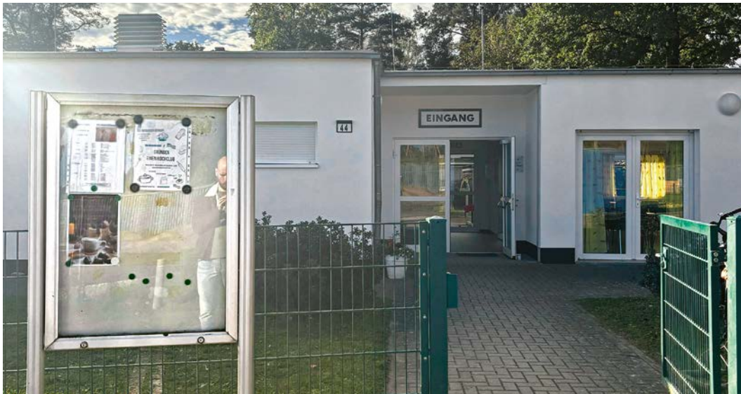
Im umgebauten Bürgerhaus Bergfelde können nun Räumlichkeiten für Veranstaltungen angemietet werden.
