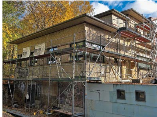
Blick auf die Kulturpumpe im 2. Bauabschnitt.
