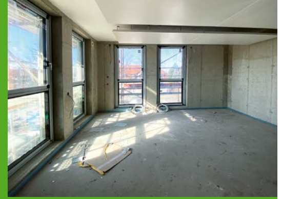
Raum mit viel Lichteinfall.
