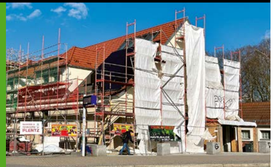
Aktueller Blick auf das Bauprojekt Kulturbahnhof.
