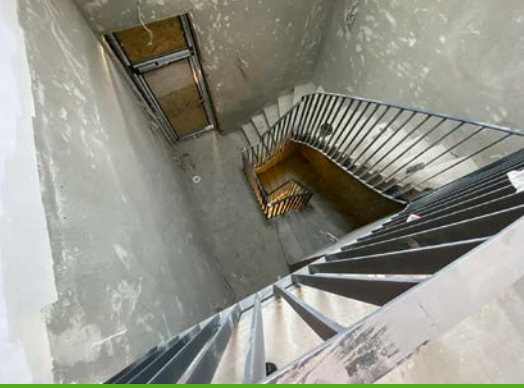
Blick in das Treppenhaus.
