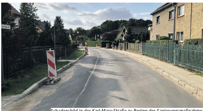
Schadensbild in der Karl-Marx-Straße zu Beginn der Sanierungsmaßnahme.
