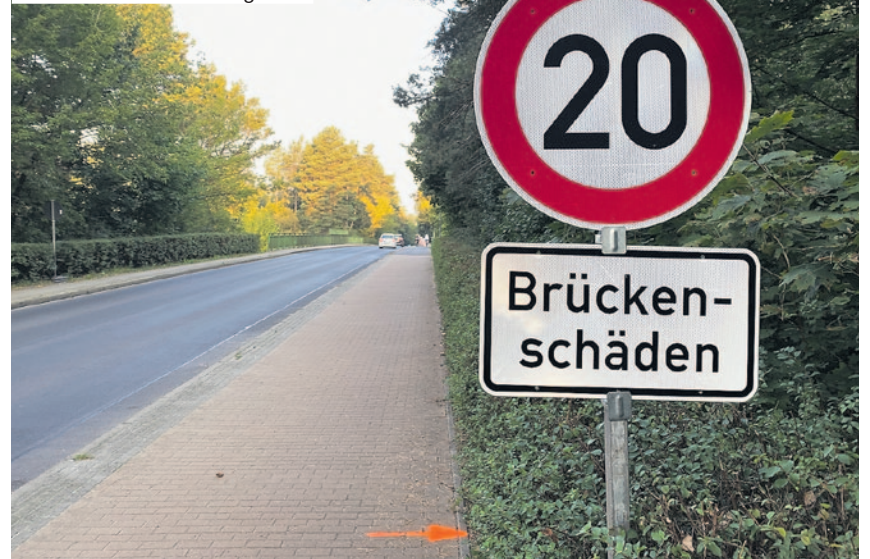
Um weiteren Schäden an der Brücke zwischen Hohen Neuendorf und Bergfelde vorzubeugen, muss das Tempo hier auf 20km/h gedrosselt werden. Der Bus- und Schwerlastverkehr wird umgeleitet.
