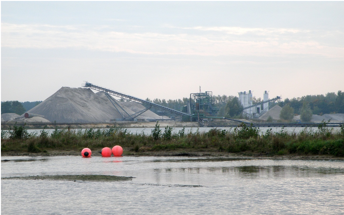
Abbildung 8: Förderanlage des Abbaufeldes SO I im Oktober 2013
