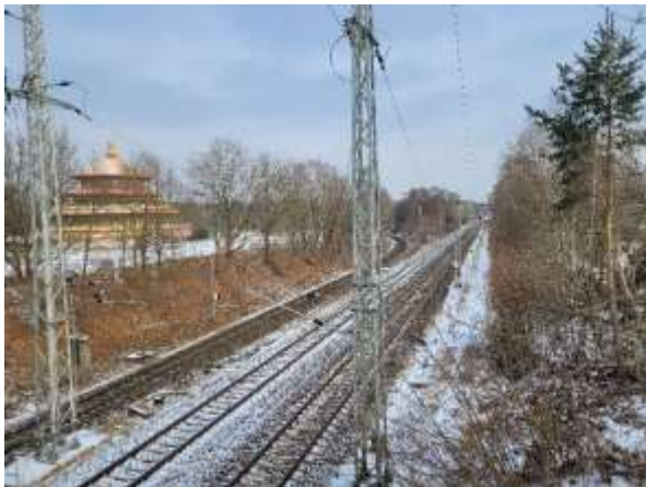
Abbildung 12: Bahnstrecken 6087 und 6089 sowie Pagode (Osten)
