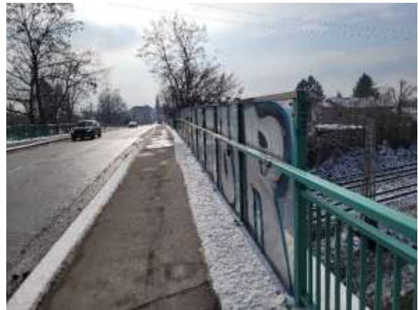
Abbildung 13: Brücke über Bahnanlagen im Zuge der Oranienburger Straße (Süden)
