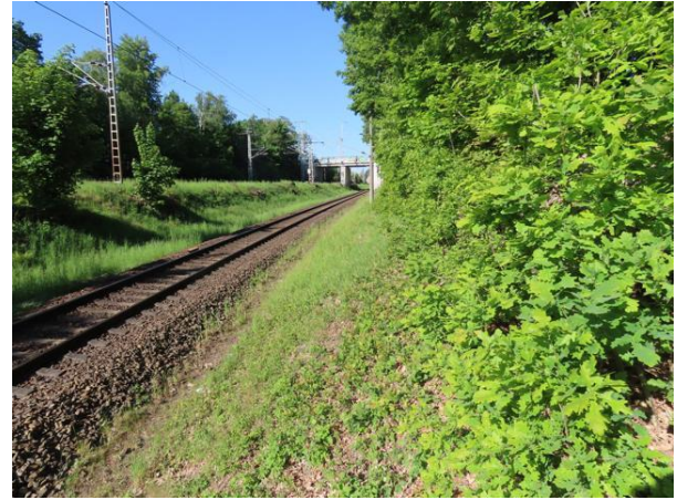
Abb. 3: Bahntrasse im Südosten
