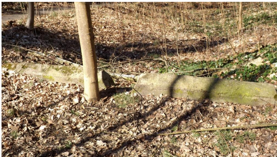
Abb. 7-17: Nördliche Betonschwelle mit Überlauf.
