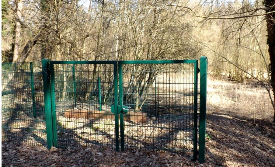
Abb. 7-3: Einzäunung des Auslaufbauwerks am Kleinen Rotpfuhl.
