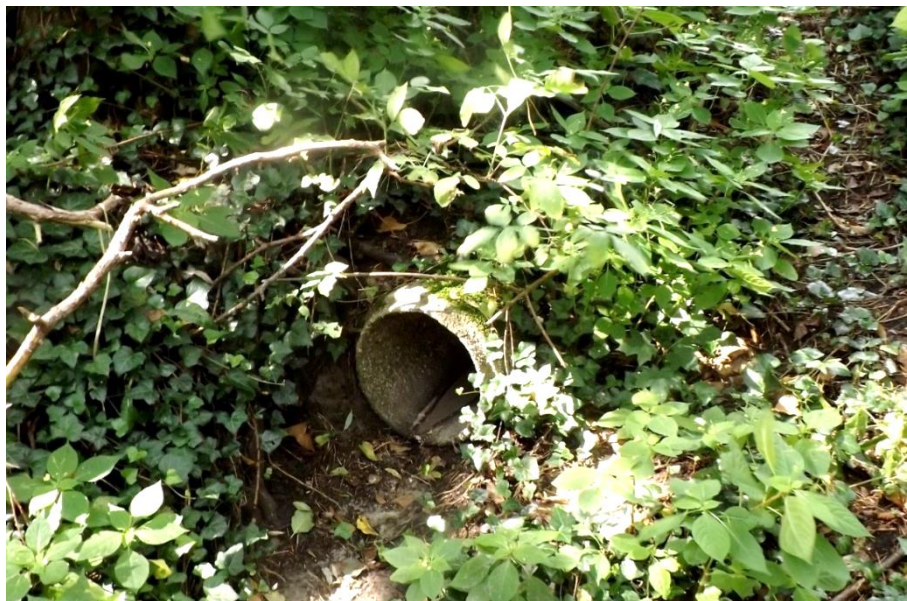
Abb. 3-10: Kleiner Regenwassereinlauf westlich des Großen Rotpfuhls.
