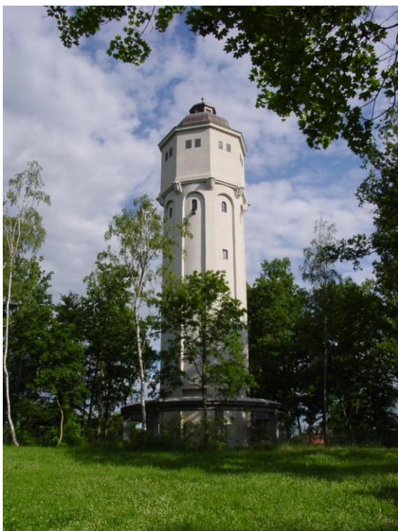
Abb.37: Westansicht Wasserturm vom Park
