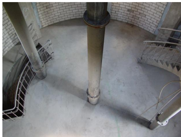
Abb.40: Zwischenebene im Wasserturm
