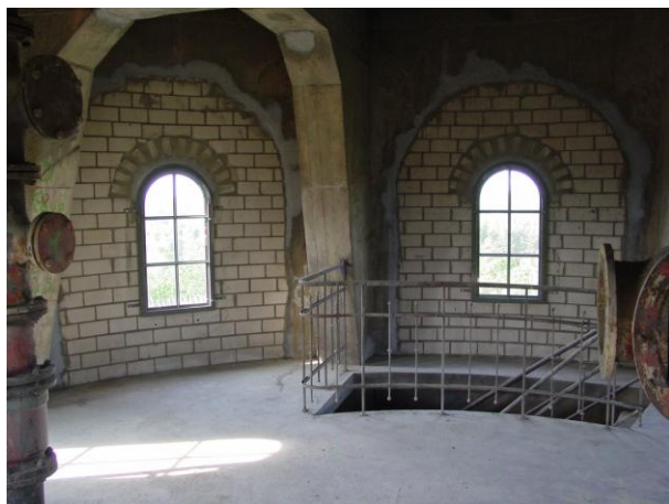
Abb.39: Aussichtsplattform im Wasserturm
