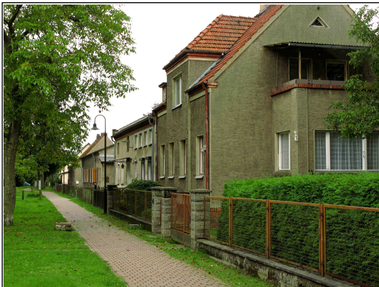
Bild 14: Dorfstraße 26-23 Stellung der Baukörper in der traditionellen Bauflucht; teils dorfuntypische Einfriedungen; im Vordergrund Haus Nr.26 mit Walmdach-Zwerggiebel über flachem Risalit
