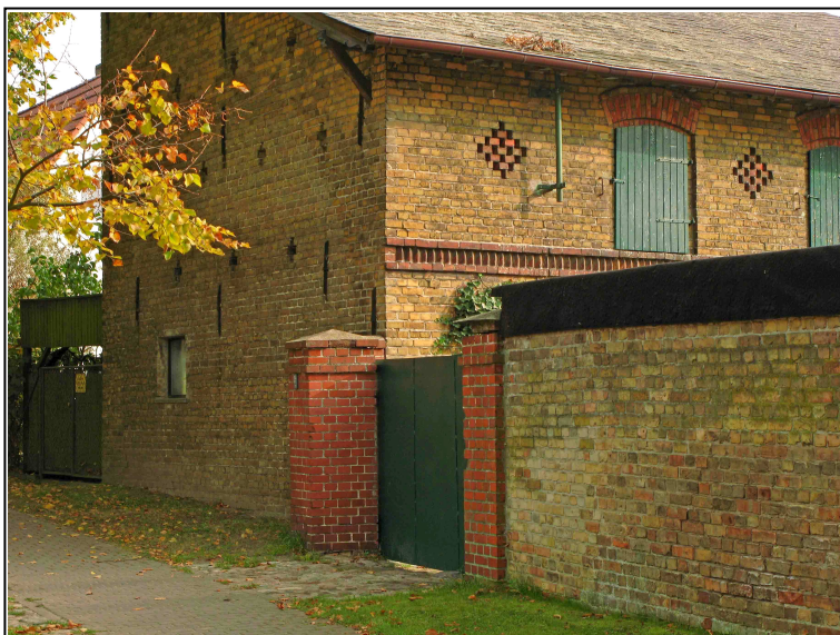
Bild 9: Dorfstraße 9 Nebengebäude zu einem ehemaligen Bauernhof mit ortsbildprägender Wirkung
