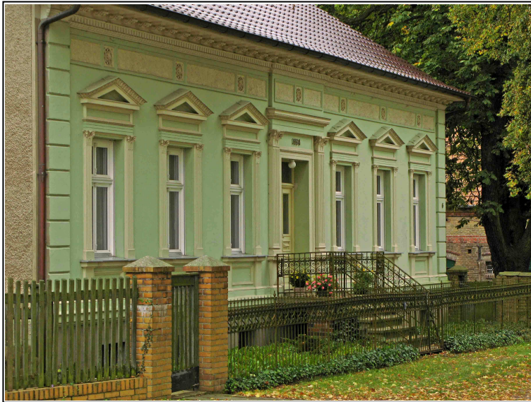
Bild 1: Dorfstraße 6 Wohnhaus (datiert 1884) mit ursprünglicher Fasadengestaltung und traditioneller Einfriedung (senkrecht gegliederter Holzlatten- und Metall- gitterzaun)
