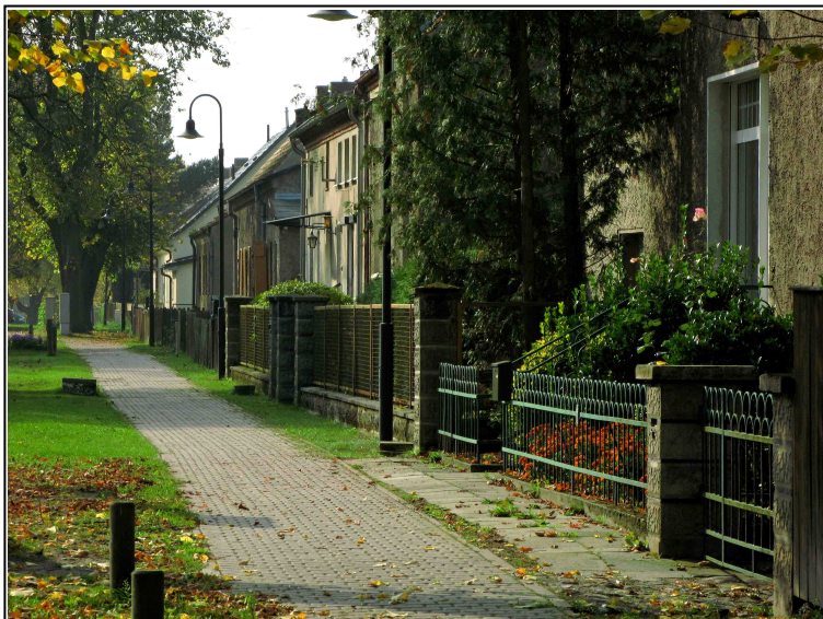
Bild 15: Dorfstraße 27-22 Stellung der Baukörper in der traditionellen Bauflucht; teils dorfuntypische Einfriedungen
