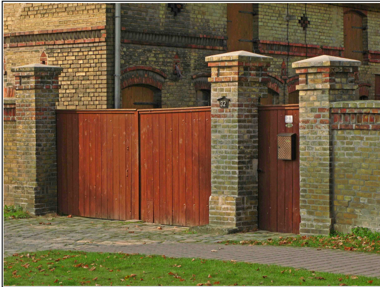
Bild 10: Dorfstraße 32 Traditionelle Einfriedung mit ortsbildprägender Wirkung zu einem ehemaligen Bauernhof
