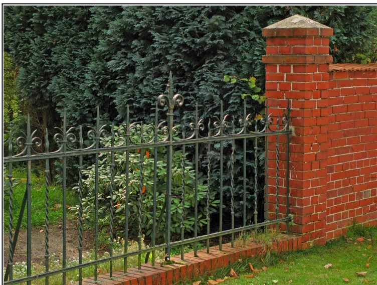
Bild 12: Dorfstraße 9 Traditionelle Einfriedung mit ortsbildprägender Wirkung zu einem ehemaligen Bauernhof (senkrecht gegliederter Metallgitterzaun mit Sockelmauer, Hofmauer und Mauerpfeiler aus Ziegelsichtmauerwerk)
