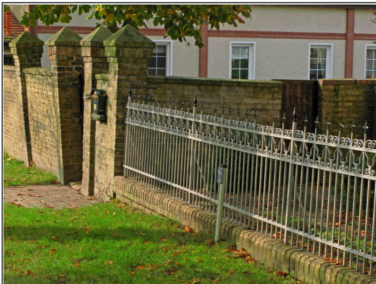
Bild 11: Dorfstraße 17 Traditionelle Einfriedung mit ortsbildprägender Wirkung zu einem ehemaligen Bauernhof (senkrecht gegliederter Metallgitterzaun mit Sockelmauer, Hofmauer sowie Tor- und Mauer- pfeilern aus Ziegelsicht- mauerwerk)
