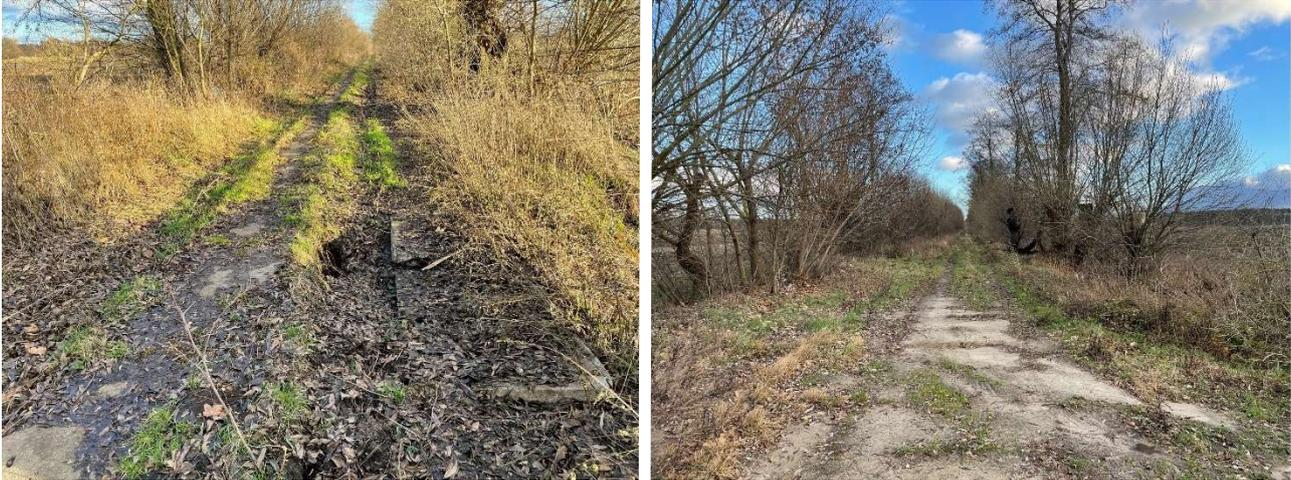
Abbildung 3: Schäden an Spurplattenweg (links), Bestandsbaumreihe (rechts)
