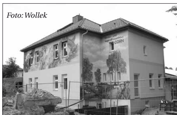
Noch Baustelle: Birkenwerders neuer Jugendclub
