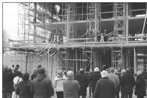
Stadtverordnete, Baufirmenvertreter und Verwaltungsmitarbeiter machten sich ein Bild vom Rohbau.
