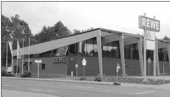
Der erste Bauabschnitt am HDZ in Bergfelde, Neubau und Eröffnung einer neuen Rewe-Filiale, wurde erfolgreich abgeschlossen
